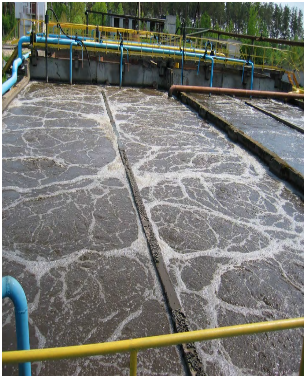
СИСТЕМА АЭРАЦИИ «БЕЛЭКПОЛЬ» НА ОЧИСТНЫХ СООРУЖЕНИЯХ КАНАЛИЗАЦИИ г. СКИДЕЛЬ (БЕЛАРУСЬ)
